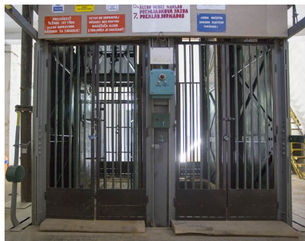
Pohľad na hlavné nárazisko šachty č. IV
