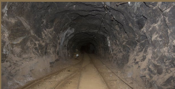
Hlavná dedičná štôlna pod elektrárnou
